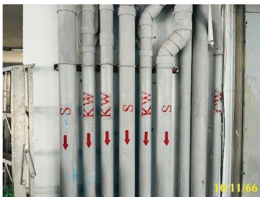
ท่อระบายน้ำทิ้ง และท่อระบายน้ำฝน
