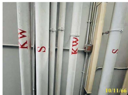
ท่อระบายน้ำทิ้ง และท่อระบายน้ำฝน
