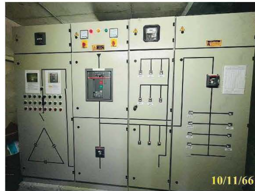
แผงจ่ายไฟฟ้าหลัก (Main Distribution Board; MDB)
